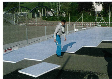
Verlegen der Unterlagsplatten
