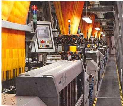
Abb. 3: VTR33 für italienischen Samt, installiert in Indien
