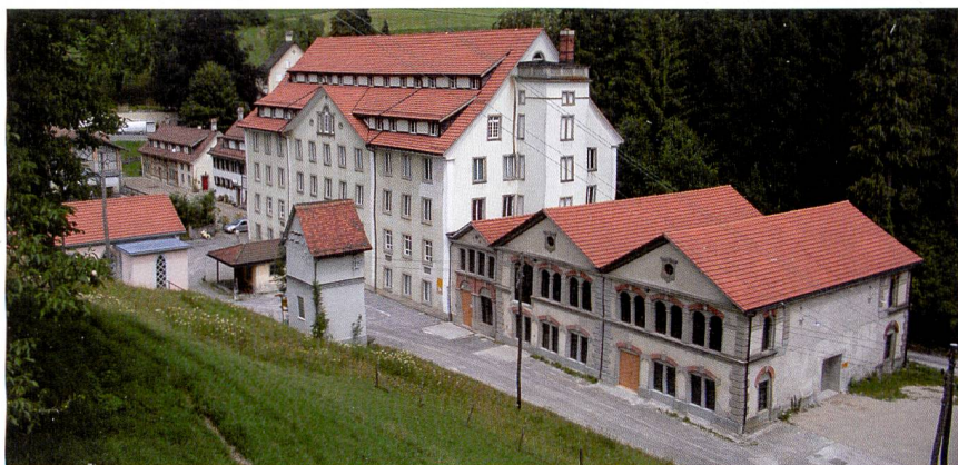
Abb. 1: Das Spinnereigebäude in Neuthal
