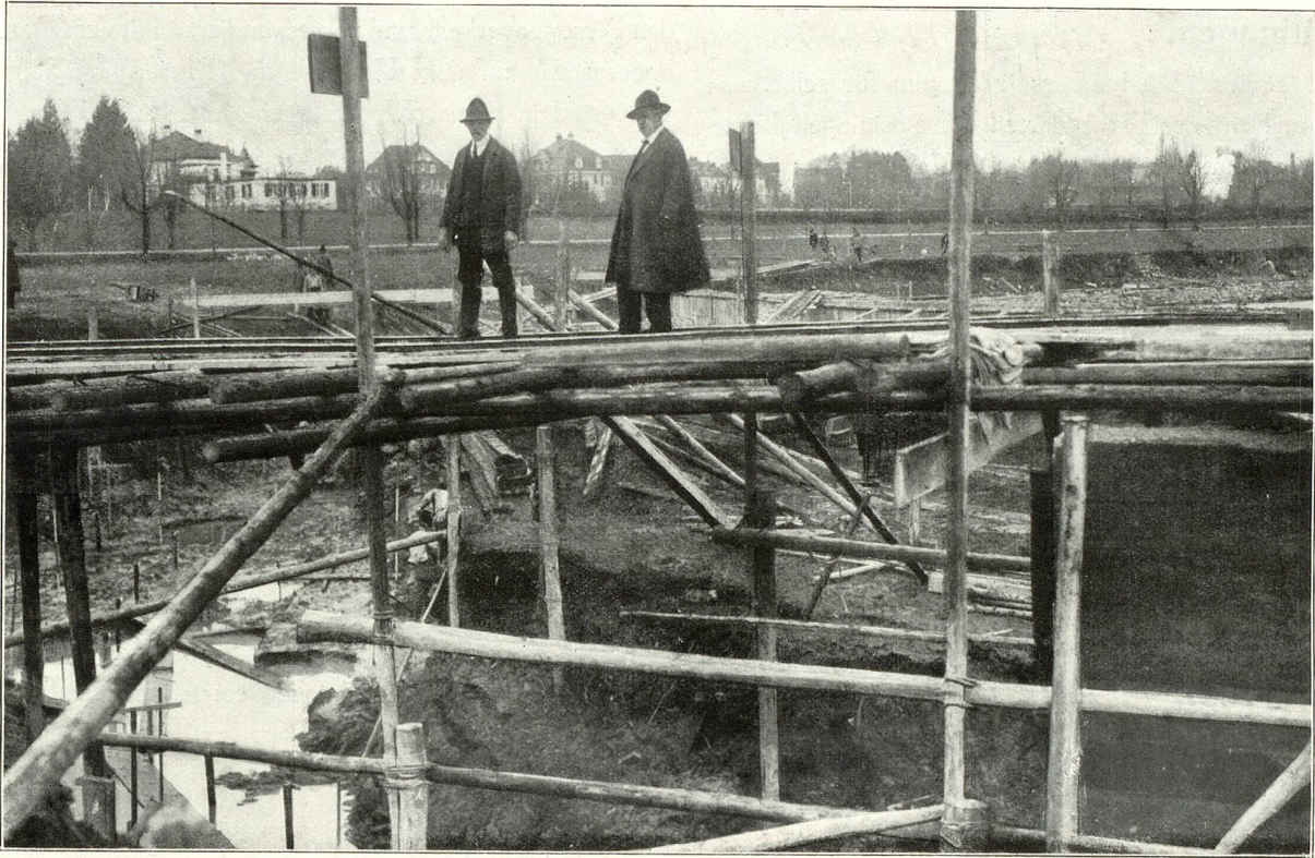
Hafen im Bau begriffen.
