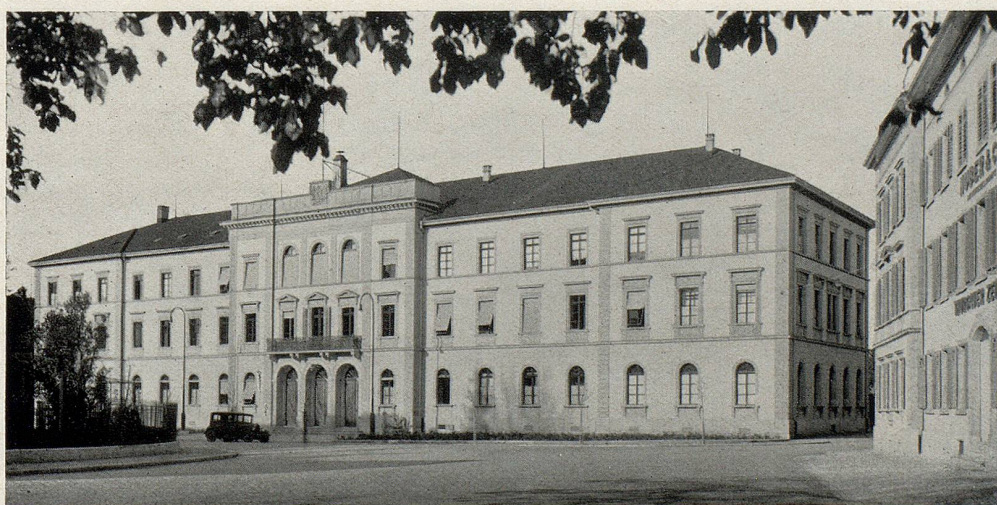
Das Regierungsgebäude nach der Renovation.
