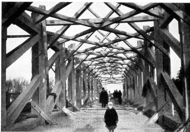
Das kunstvolle Balkengerüst der alten Brücke
