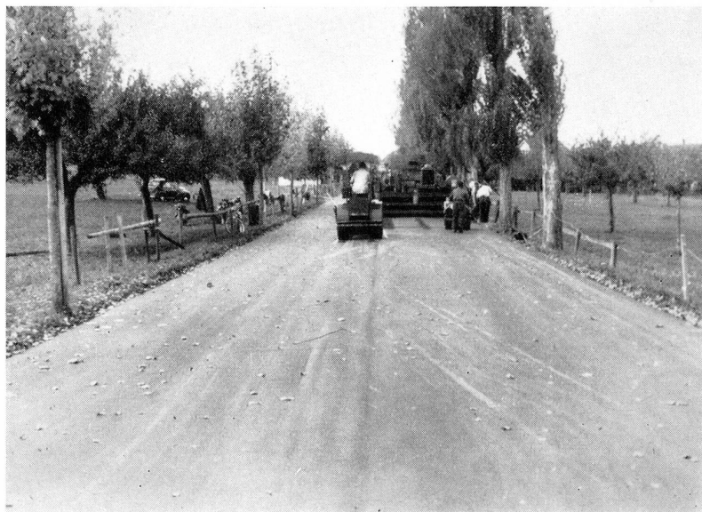
Einbau Teppichbelag Erlen mit Straßenfertiger
