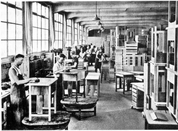
Teilansicht der Möbelfabrikation: Zusammenbau und Beizen
