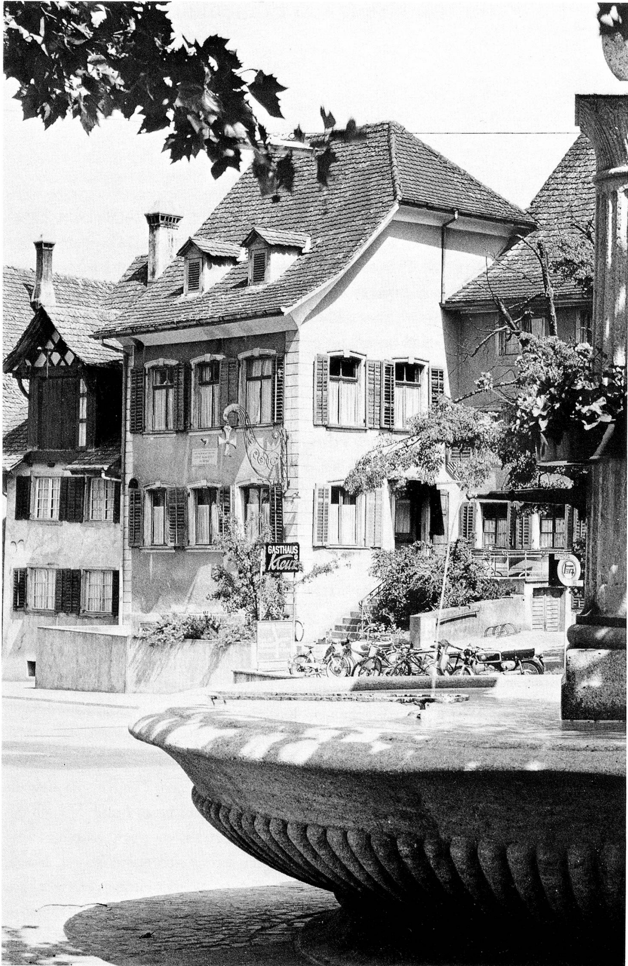
Vor der Renovation.
