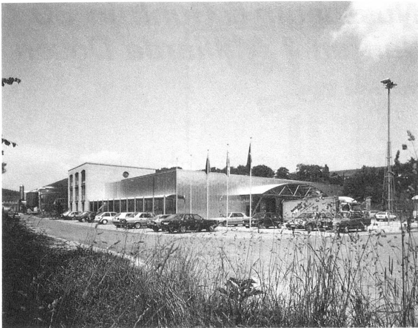
Das Nussbaum & Guhl-Stammhaus: Der Bau, der 1988 bezogen werden konnte, ermöglicht effiziente Betriebsabläufe.
