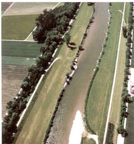
Abbildung 7: Abschnitt Ror-Uesslingen. Die neu gestaltete Thur oberhalb Uesslingen; Mittelgerinne mit Aufweitungen und Kiesbänken. Blickrichtung flussabwärts
