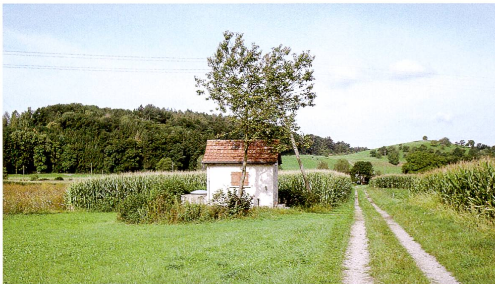
Abbildung 3: Grundwasserfassung mit Pumpenhaus und Fassungschacht.
