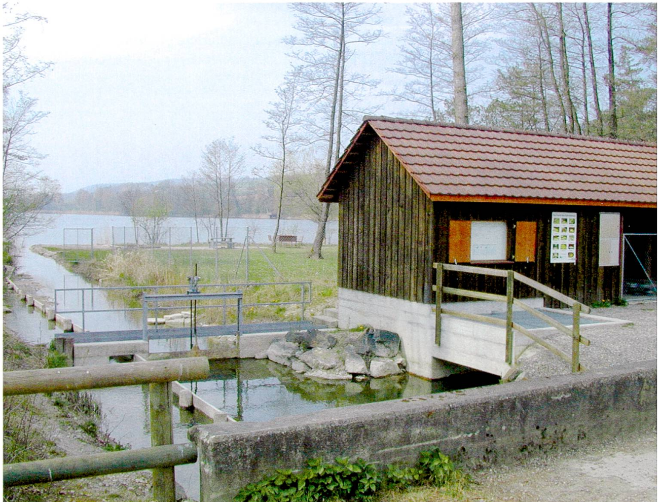
Abbildung 5: Die Tiefenwasserableitung am Hüttwilersee.
