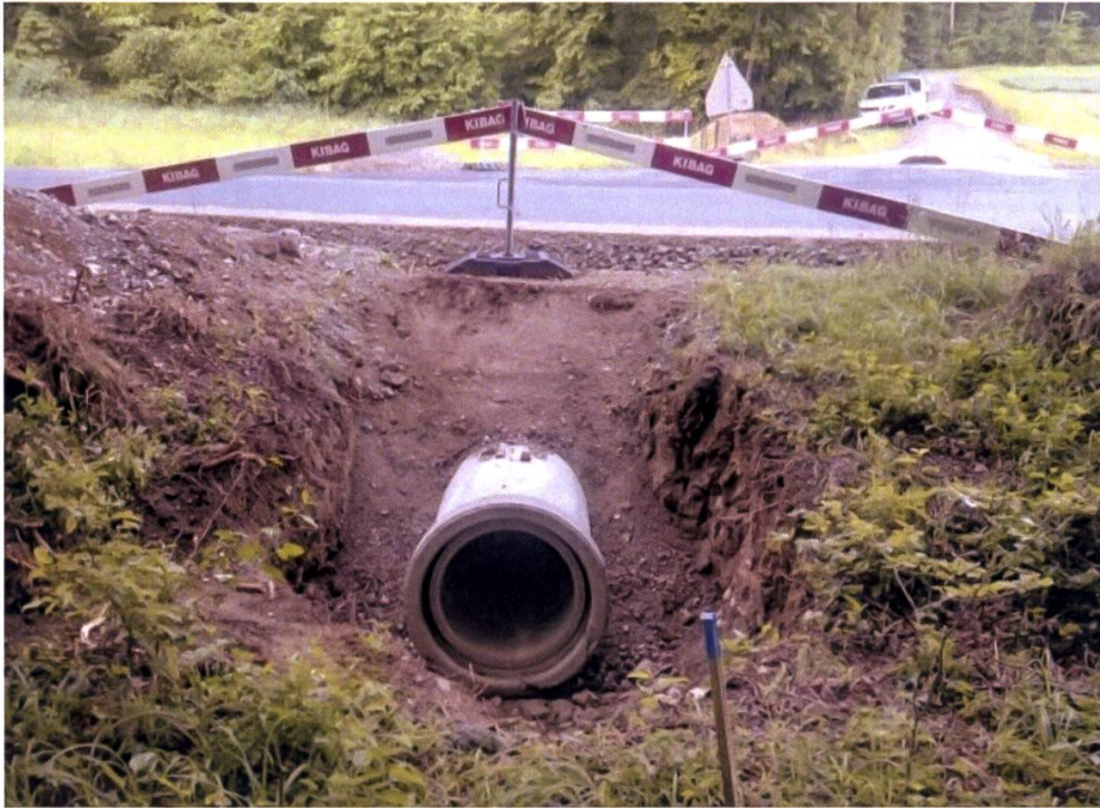
Abbildung 4: Situation während der Erstellung des Durchlasses auf östlicher Strassenseite. Foto: Kim Krause.
