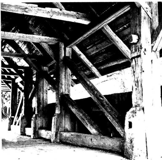
Innenansicht der ältesten Toggenburger Holzbrücke
