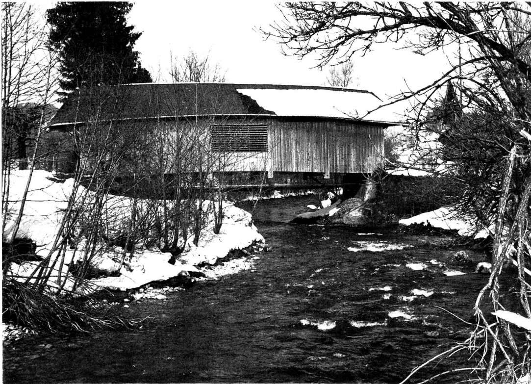
Neckerbrücke Brunnadern flussabwärts
