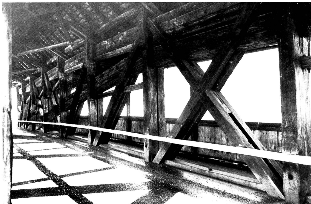
Balkenwerk der Lütisburger Thurbrücke
