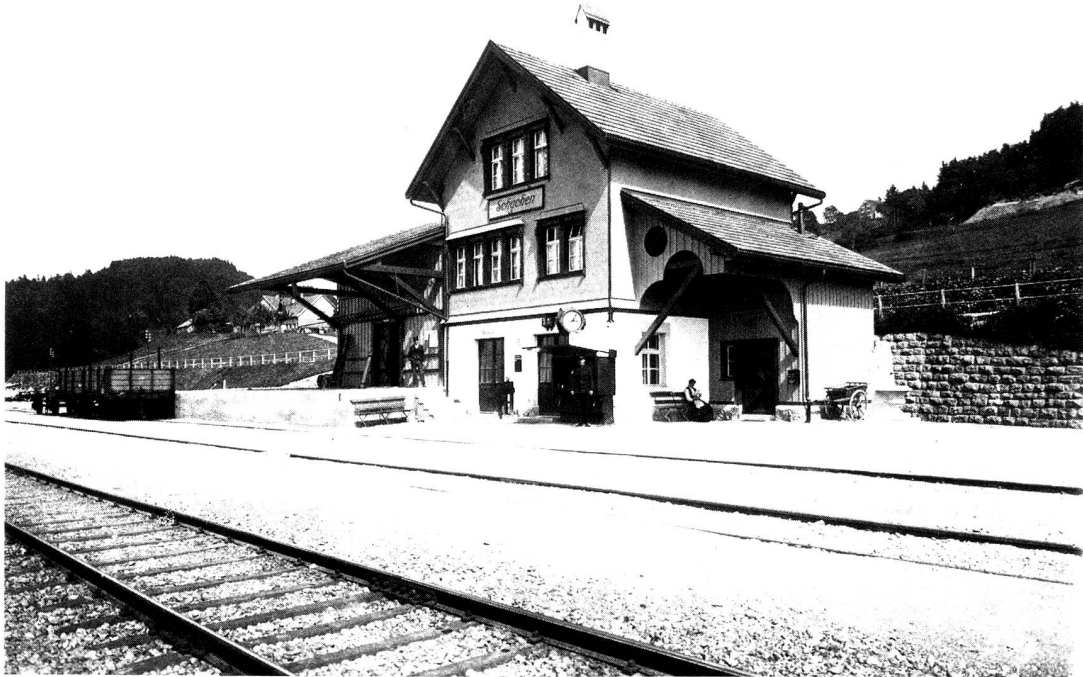
Abb. 3 Stationsgebäude in Schachen
