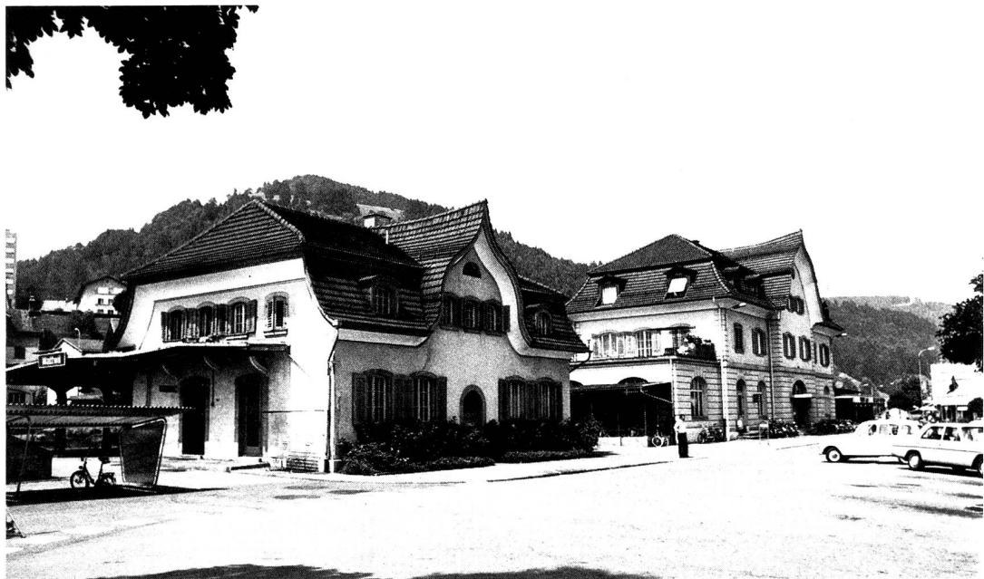
Abb. 9 Stationsgebäude in Wattwil (SBB)
