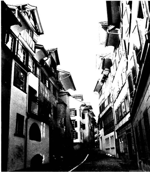
Löwengasse in Lichtensteig. Malerischer Strassenraum mit immer neuen denkmalpflegerischen Ueberraschungen. Typisch für das Städtchen die von Aufzugslukarnen unterbrochene Trauflinie
