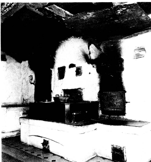
Lүpfertwil ob Ebnat, Wohnhaus des Orgelbauers Josef Looser, erbaut 1781. Küche mit offenem Kamin und den beiden Feuerstellen für die Stubenöfen. – Rutenkamin in Pyramidenform im Obergeschoss und Treppengeländer aus der Bauzeit.
