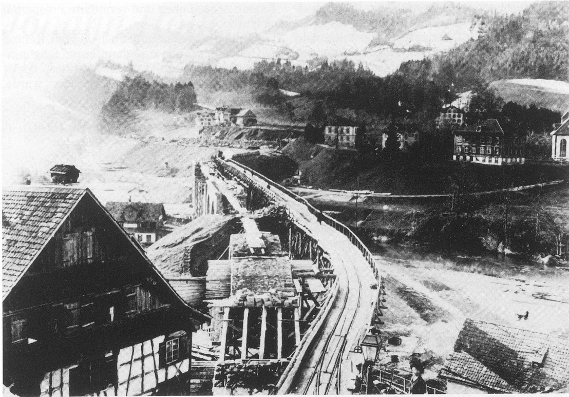
BT-Bahnbau Bahnhof Lichtensteig. Rohbauarbeiten für Viadukt zum Bahnhof. Stand der Arbeiten 25. November 1908.
