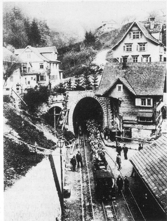
Westportal bei Lichtensteig. Einweihung 6. April 1909 des Wasserfluchtunnels.
