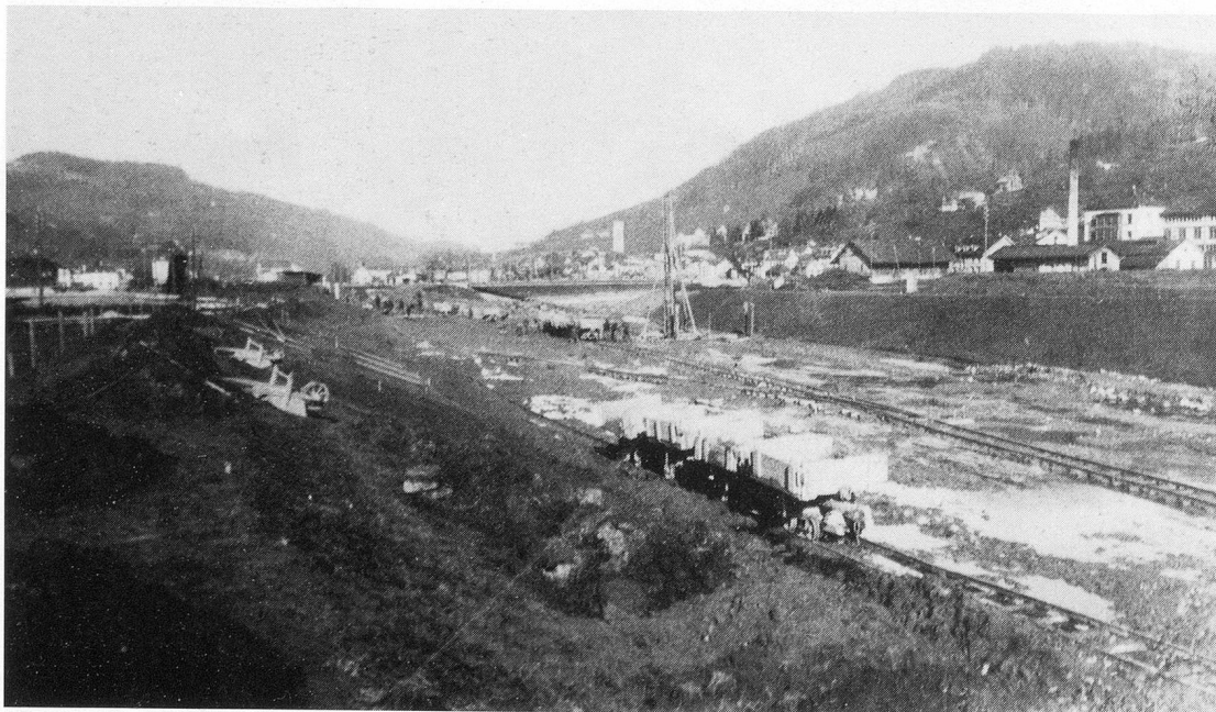
Wattwil: Thurkorrektur. Durchstich oberer Teil. 1909.
