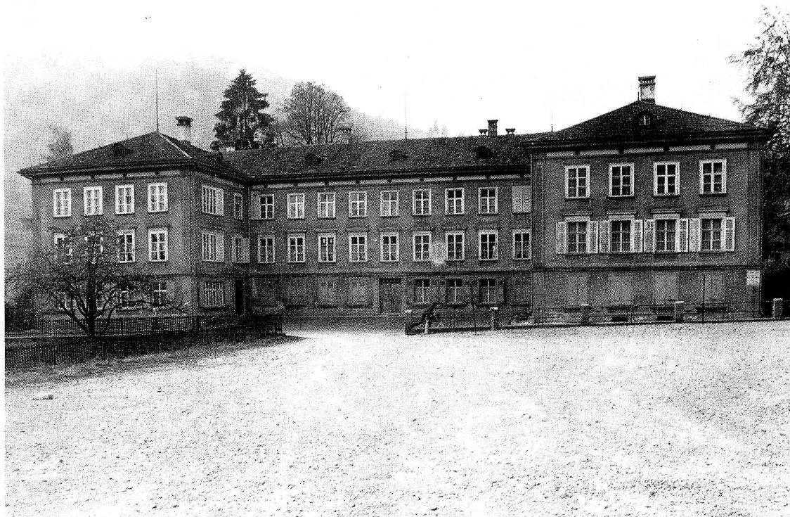
Wattwil. Das weltweit engagierte Handelshaus der Unternehmerfamilie Raschle wurde um 1852 gebaut und diente bis 1917 als Zentrum des Toggenburger Textilimperiums. Von hier aus wurden die Webereien in der Rietwies (Wattwil) und im Soor (Bütschwil) sowie im Necker geleitet. Die herrschaftliche, hufeisenförmige Anlage beherrschte den Rössliplatz nach Westen, musste aber der jüngsten Globalüberbauung weichen. – Foto: B. Anderes, 1981.
