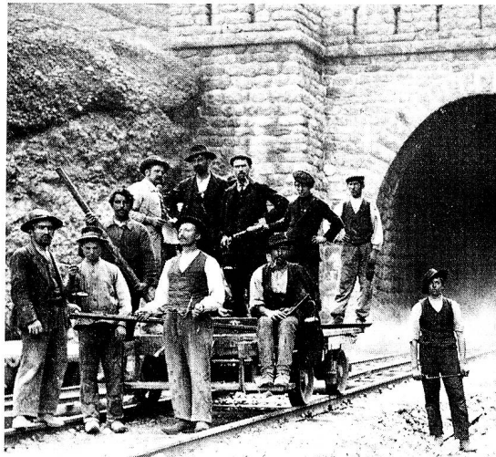
Der Bau der Bodensee-Toggenburg-Bahn und des SBB-Tunnels durch den Ricken 1909–11 verbanden das Toggenburg und das südliche Gebiet des Kantons St.Gallen enger mit der Kapitale und öffnete zugleich ein Tor zur Innerschweiz und zum Gotthard. – Arbeiter vor dem nördlichen Portal des Wasserfluhstunnels bei Brunnadern, um 1910. – Foto: Albert Lichtensteiger, Dietfurt.
