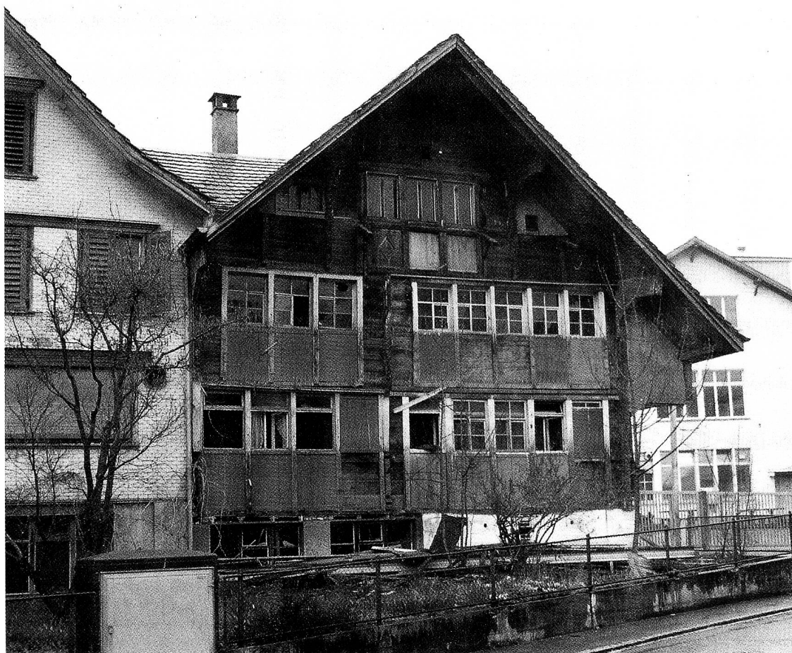
Flawil, Müligass 28. Ehemaliger Strickbau von 1636, abgebrochen 1994. Zur Zeit eingelagert und für eine Versetzung nach Niederstetten Uzwil bestimmt.
