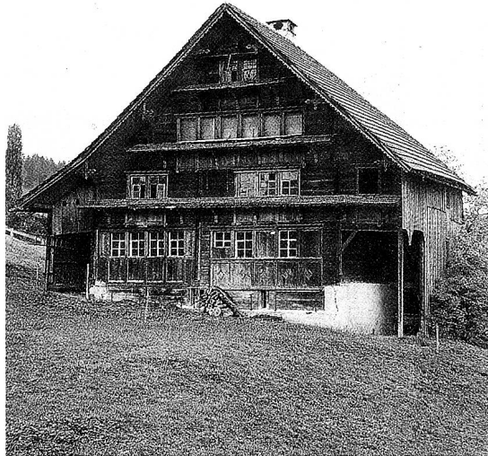
Oben: Haus in Füberg Oberhelfenschwil, erhöht 1752. Zustand 1949. – Unten das versetzte Haus während des Wiederaufbaus im «Acker» nordwestlich von Ebnat, 1950.
