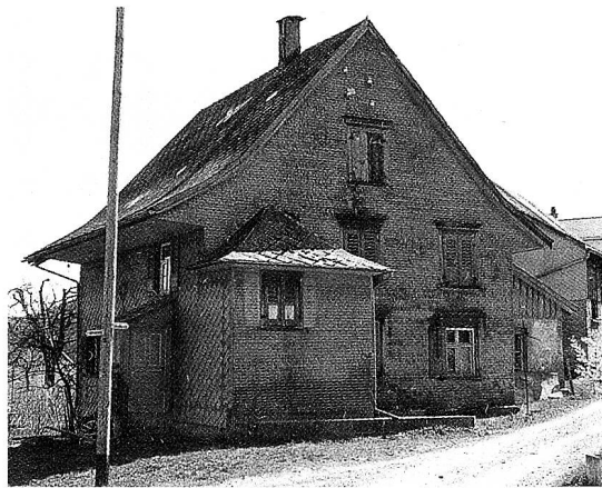
Mosnang. Ehemaliges Haus auf dem Schönenberg ob Dreien, Rückfront. Zustand vor 1984.
