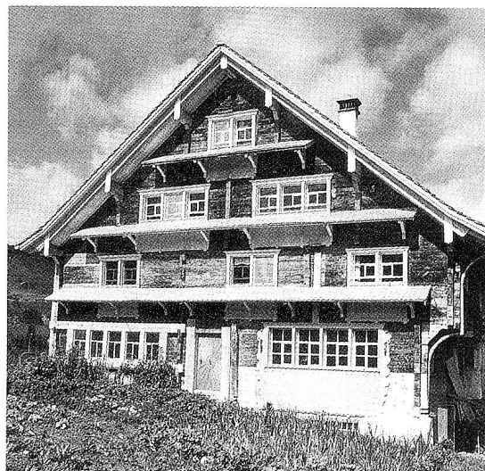
Oben: Während des Wiederaufbaus 1992/93 auf Büel Nesslau. – Mitte: Zustand des Hauses auf Luttenwil vor dem Abbruch 1991. Davor die Bauweise des heutigen Ersatzhauses. – Unten: Heutiger Zustand.
