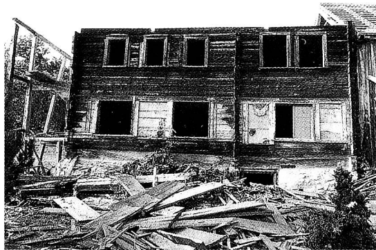
Haus in Allenwinden ob Rüeterswil während der Zerlegung 1990.
