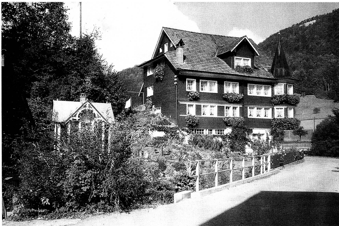
Der «alte Hirschen» unterhalb der Furthsäge am linken Ufer des Schwendibachs (Gemeindeboden von Brunnadern). Das stattliche Erkerhaus gehörte der Müllerfamilie Brunner. Der Gartenpavillon stand ursprünglich auf dem Fabrikgelände gegenüber. – Foto B. Anderes.
