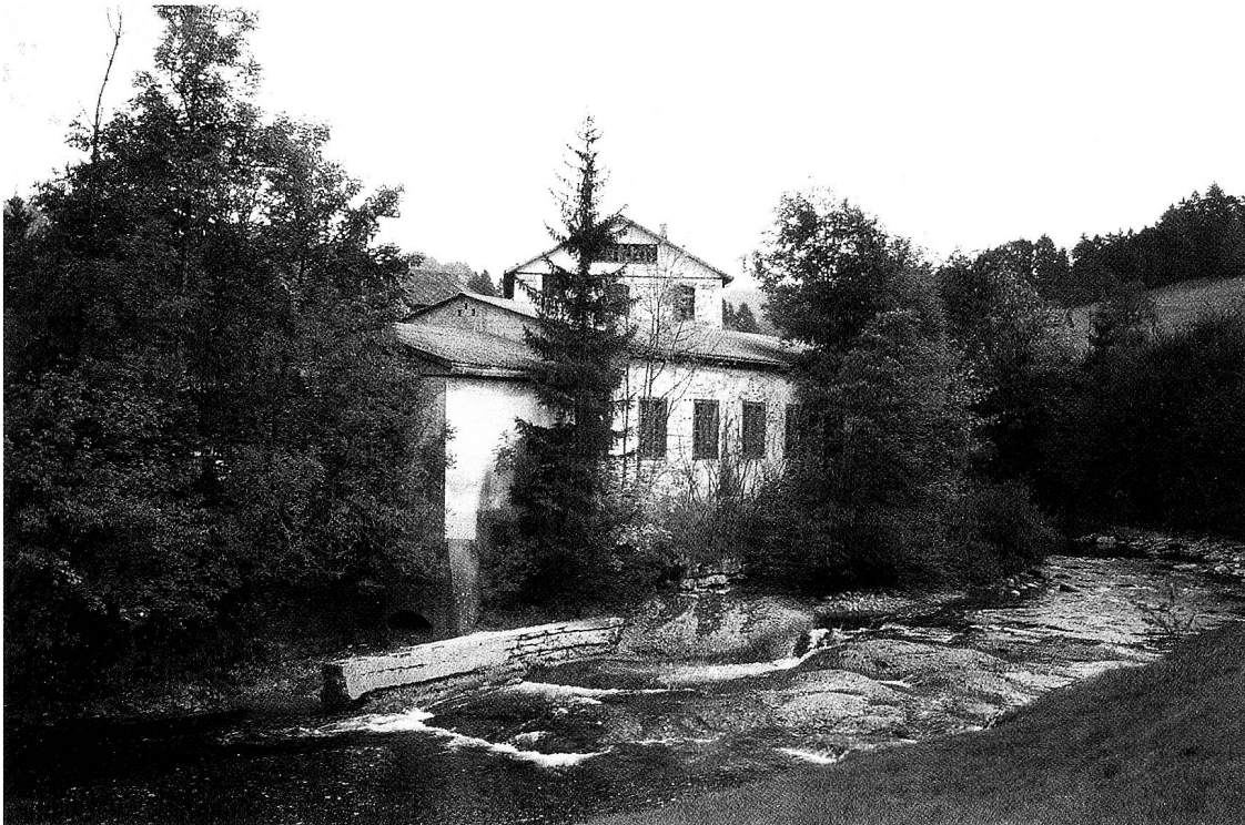
Die nach dem Zweiten Weltkrieg stillgelegte Weberei in der Furth bezog ihre Energie einerseits von einem Kanal am Necker, andererseits von einem 1867 erstellten, den Necker überquerenden Rohr, welches Wasser vom Schwendibach unterhalb der Furthmühle abzweigte. – Foto B. Anderes.
