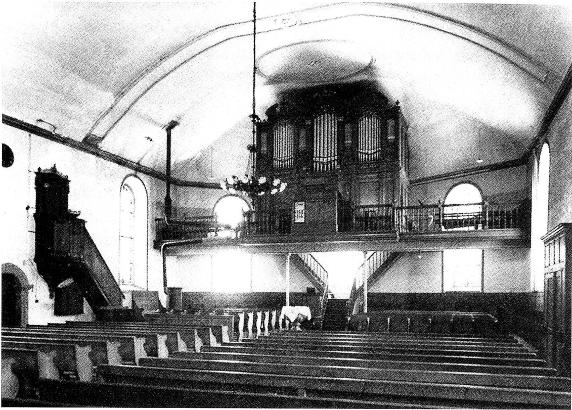
Ehemalige Chororgel in der ref. Kirche Nesslau, erbaut von Fr. Goll 1899, abgebrochen und auf die hintere Empore versetzt 1952. – Alte Foto.
