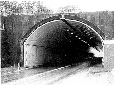
Tunnelsanierung im Chessel Tobel.
