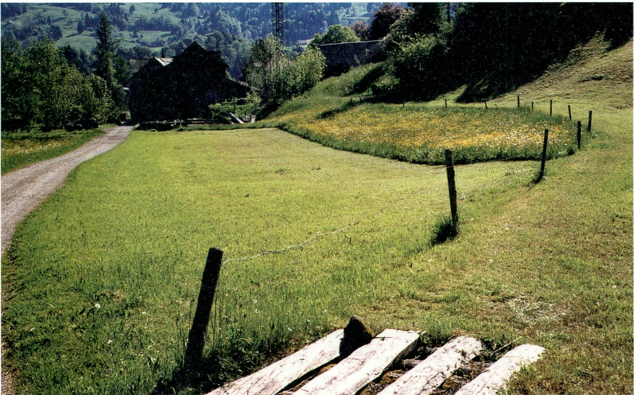
Trasse des eingedeckten Oberwasserkanals Richtung Herrenmühle.
