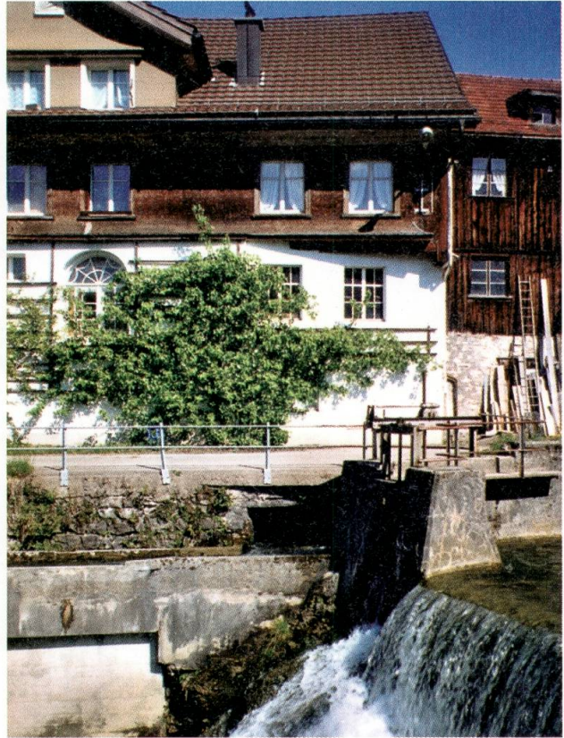
Bild links: Wehr und Einlaufbauwerk Herrenmühle mit Oberwasserkanal und Überlauffalle. Bild rechts: Herrenmühle mit dem westlichen Teil, in dem sich früher die Mühlenanlage mit separatem Wasserrad befand. In der Mitte der Auslauf des Unterwassers in den Oberwasserkanal der Anlage Meyer-Mayor. Letzterer und der einstigen Ausäuge dient auch das Wehr mit Einlaufbauwerk, damit diese auch betrieben werden können, wenn die Herrenmühle ausser Funktion ist.
