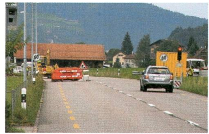
Die Brücke über den Gerenbach wird ersetzt.
