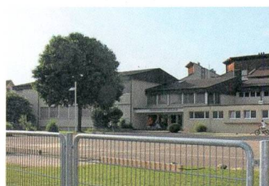
Das sanierungsbedürftige Primarschulhaus Schwarzenbach.
