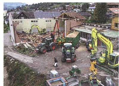
Abbruch der Turnhalle.
