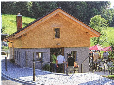
Das neue Waschhaus, das keines mehr ist.
