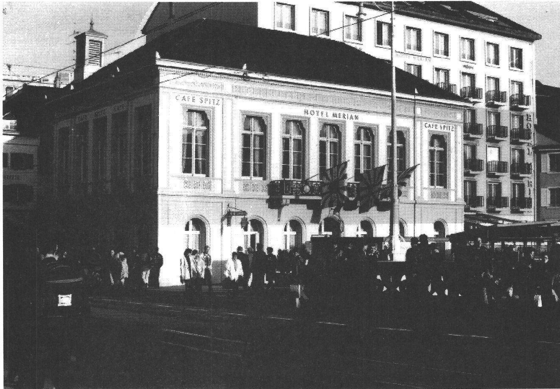
Eines der teuren Arbeitsrappen-Projekte war die Renovation des Café Spitz am Kleinbasler Kopf der Mittleren Brücke, prozyklisch durchgeführt in der guten Konjunktur der frühen 1970er Jahre. (Photo: Greta Schindler, Januar 1996)
