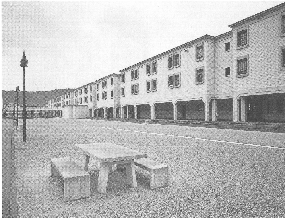
Abb. 8: Justizvollzugsanstalt Pöschwies, 1995 bis heute. 1995 wird der Neubau der Einrichtung als Ersatz für die kantonale Strafanstalt Regensdorf (Bau 1901) mit 320 Zellen in Betrieb genommen. Zwei Jahre später wird für den Vollzug von kurzen Strafen der Erweiterungsbau mit 60 Einzelzellen eröffnet, die seit 2004 doppelt belegt sind. Damit verfügt die Justizvollzugsanstalt Pöschwies heute über 460 Plätze. Gebaut wurden die neuen Gebäude derart, dass in allen Abteilungen ein Gruppenvollzug möglich ist. Jede Gebäude- und Stockwerkeinheit mit jeweils 40 respektive 20 Zellen verfügt über Räumlichkeiten, die während der Freizeit allen Insassen zur Verfügung stehen. (Foto: Peter Schulthess, 2006)
