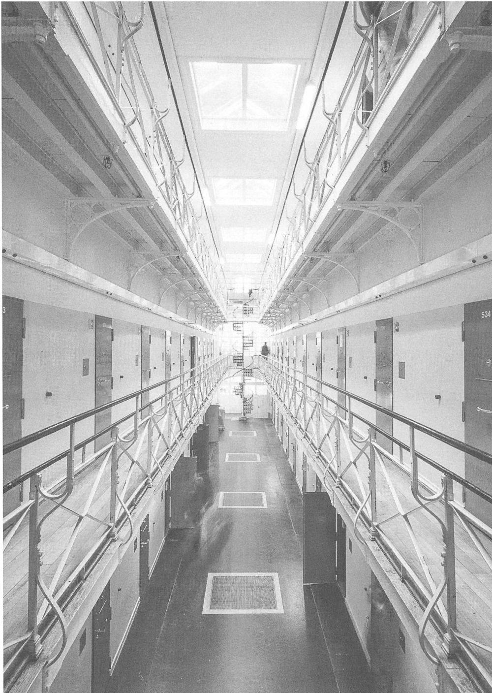
Abb. 4: Justizvollzugsanstalt Lenzburg, 1864 bis heute: Innenansicht eines Flügels, dessen Raumgestaltung der Gründungszeit entspricht. Modernisiert wurden die Türen, die Oberlichter sowie Inneneinrichtungen wie Betten oder Heizung. Im Lauf der Zeit wurden Elektrizitäts- und Wasserversorgung, Gegensprechanlagen und Störsender gegen Handygebrauch installiert. (Foto: Peter Schulthess, 2006)
