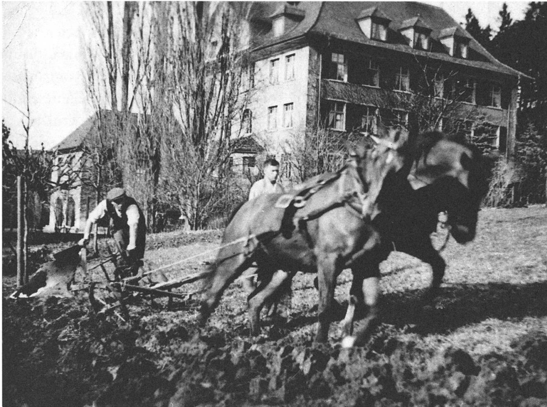
Abb. 1: Agrarische Arbeit in der Stadt: Pferde und Menschen beim Pflügen in der Stadt Zürich. Nicht datierte Fotografie aus der Zwischenkriegszeit. Im Hintergrund steht das 1910–1919 gebaute Waisenhaus Sonnenberg. (Baugeschichtliches Archiv der Stadt Zürich, e-pics: BAZ_117831)
