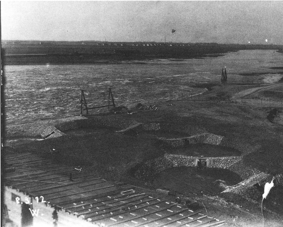
Abb. 3: Der Wildpass am rechten Weserufer, der aus mehreren Rundbecken bestand, die über schmale Schlupflöcher mit rippenartigen Ausbuchtungen verbunden waren. Die Bauweise trug die Handschrift des norwegischen Fischereiexperten Landmark. (Anonym, Bau des Weserwehrs 1909–1912, 8. 3. 1912, Bremer Staatsarchiv, Fotoalben: 10, B AL, Signatur 1520)
