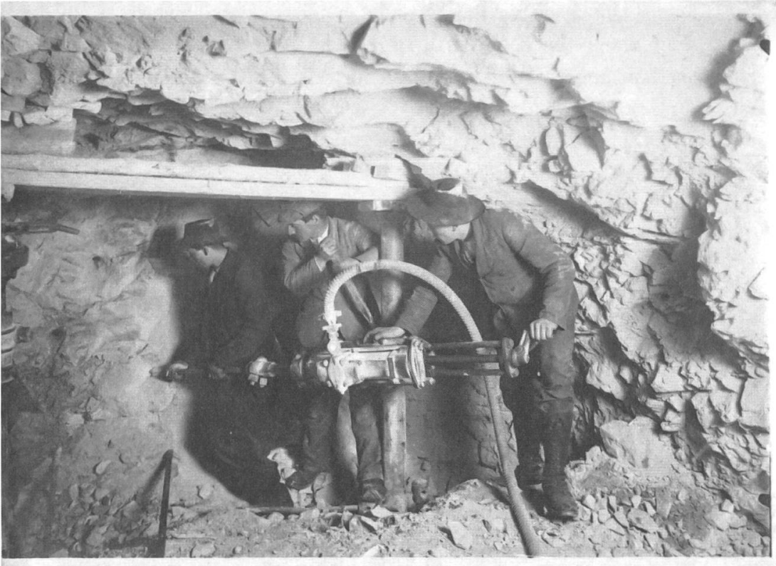
Abb. 1: Mineure beim Ansetzen der Bohrlöcher mit einer Druckluftbohrmaschine der Marke Ingersoll, Aufnahme um 1912, Fotograf unbekannt. Schweizerisches Sozialarchiv Sign. Sozarch_F_5068-Fb-1353.
