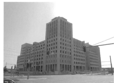
Aldo Rossi, Rohbau ruine Landsberger Allee , Berlin, Foto, 2004
