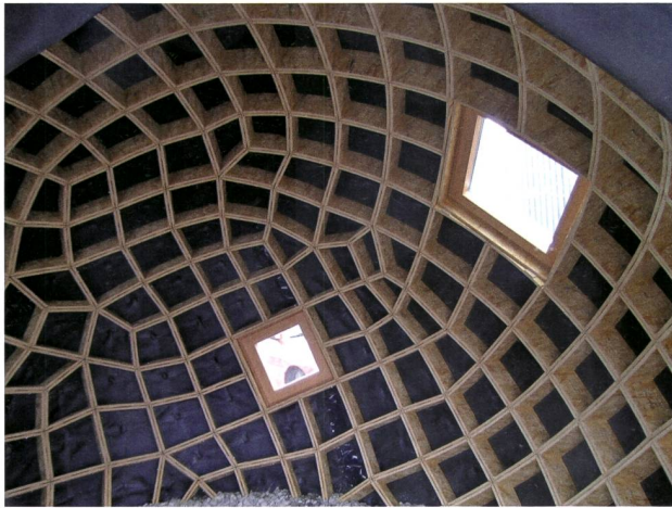
Professur für CAAD der ETH Zürich, Swissbau-Pavillon , Zürich, 2005, Foto von Adrian Blain. Die Kuppel der Swissbau-Kugel ist eine direkte Materialisierung der Java-Simulation.
