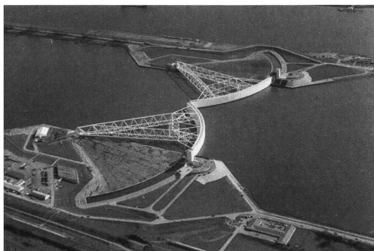
Flood protection test of the Maaslantkering in Hoek van Holland, Deltawerken, in the Netherlands, 1997, source: Ministerie van Verkeer en Waterstaat, Rijkswaterstaat.
