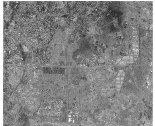
Luftbild vom Gebiet östlich der Stadtgrenze von Addis Abeba, ca. 2005. Am rechten Bildrand sind zwei vom Bauträger Ayat entwickelte suburbane Einfamilienhausquartiere anhand ihrer rasterartigen Layouts zu erkennen.
