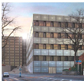
ETHZ Forschungsgebäude GLC, Bio- und Chemie-Laboratorien nahe dem Unispital, Zürich
