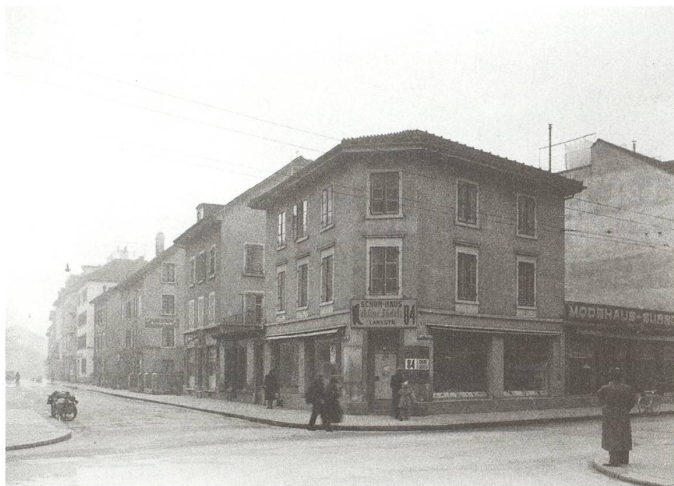
fig. b Schuh-Haus Chline Lädeli, 1946. Fotografie: Baugeschichtliches Archiv der Stadt Zürich.
