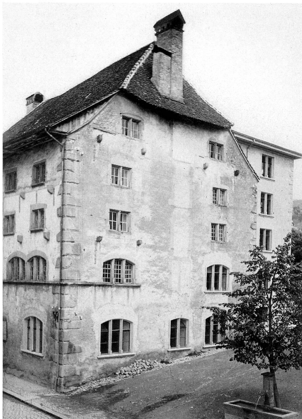
Abb. 15 Zug. Ehemaliges Kornhaus jetzt Stadt- und Kantonsbibliothek. Zustand vor der Restaurierung.
