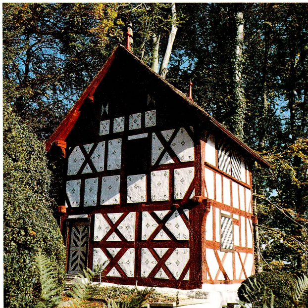
Abb. 11 Risch. Schloss Buonas. «Rebhüsl» mit freigelegtem Fachwerk und schablonierter Ornamentierung der Putzfelder nach der Restaurierung.
