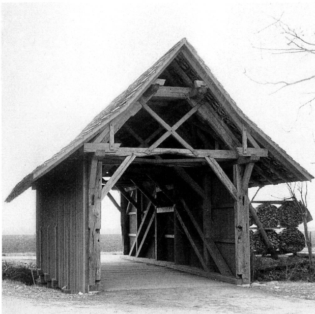
Abb. 18 Zug. Alte Steinhauserbrücke. Nach der Wiederherstellung in der Kolermühle.
