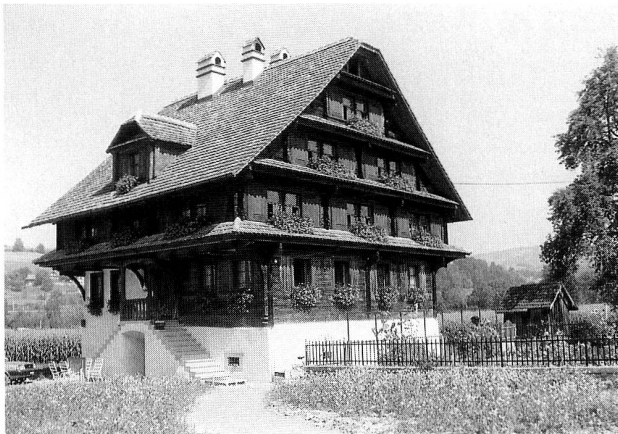
Abb. 3 Baar. Bauernhaus Sennweid nach der Restaurierung.
