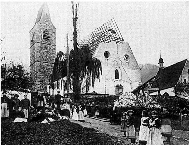
Abb. 41 Alt St. Michael: Abbruch.
