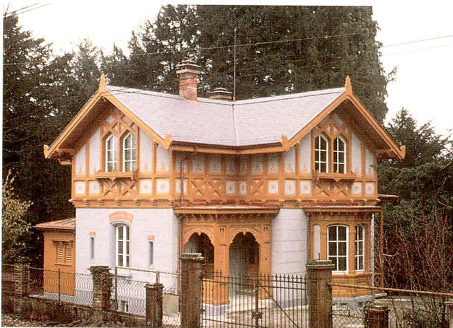
Abb. 7 Cham, Pförtnerhaus der Villa Vilette. Nach der Restaurierung 1991.
