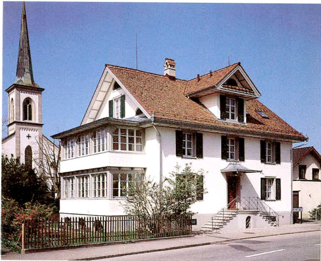
Abb. 6 Baar, ehemaliges protestantisches Pfarrhaus. Ansicht von Osten nach der Restaurierung, 1991.
