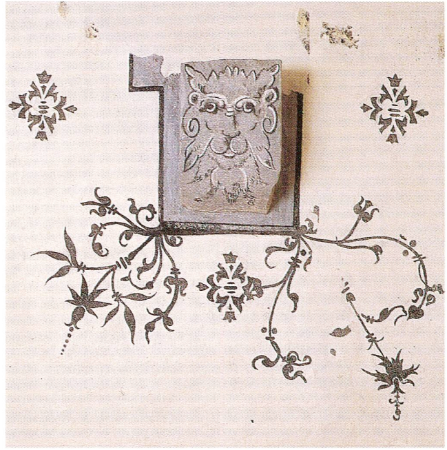
Abb. 26 Zug, St.-Oswalds-Gasse 16/18. Haus Nr. 16, 2. Obergeschoss. Die auf einen Konsolstein aufgemalte Löwenfratze, seitlich von Rankenmalereien begleitet, nach der Restaurierung 1994.
