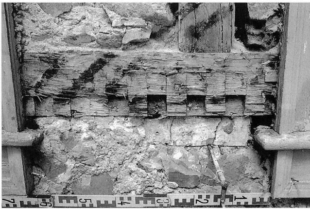
Abb. 11 Zug, St.-Oswalds-Gasse 16/18. Blick Richtung Westen auf die äussere Ostfassade des Hauses Nr. 18, während der Untersuchungen 1993. Zwischen den Fenstern im 1. Obergeschoss fanden sich Reste eines Zahnfrieses, der ursprünglich die Brüstung der Fenster betonte. Dieser Fries sowie rote Farbreste in den Zahnzwischenräumen belegen, dass der ursprüngliche Blockbau holzsichtig gewesen ist.
