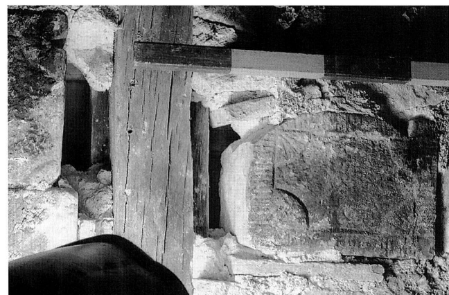
Abb. 9 Zug, St.-Oswalds-Gasse 16/18. Mauerwerk im 1. Obergeschoss mit eingefügten Holz- und Steinspolien, während der Untersuchung 1993. Einteilung der Messlatte in 10 cm.
