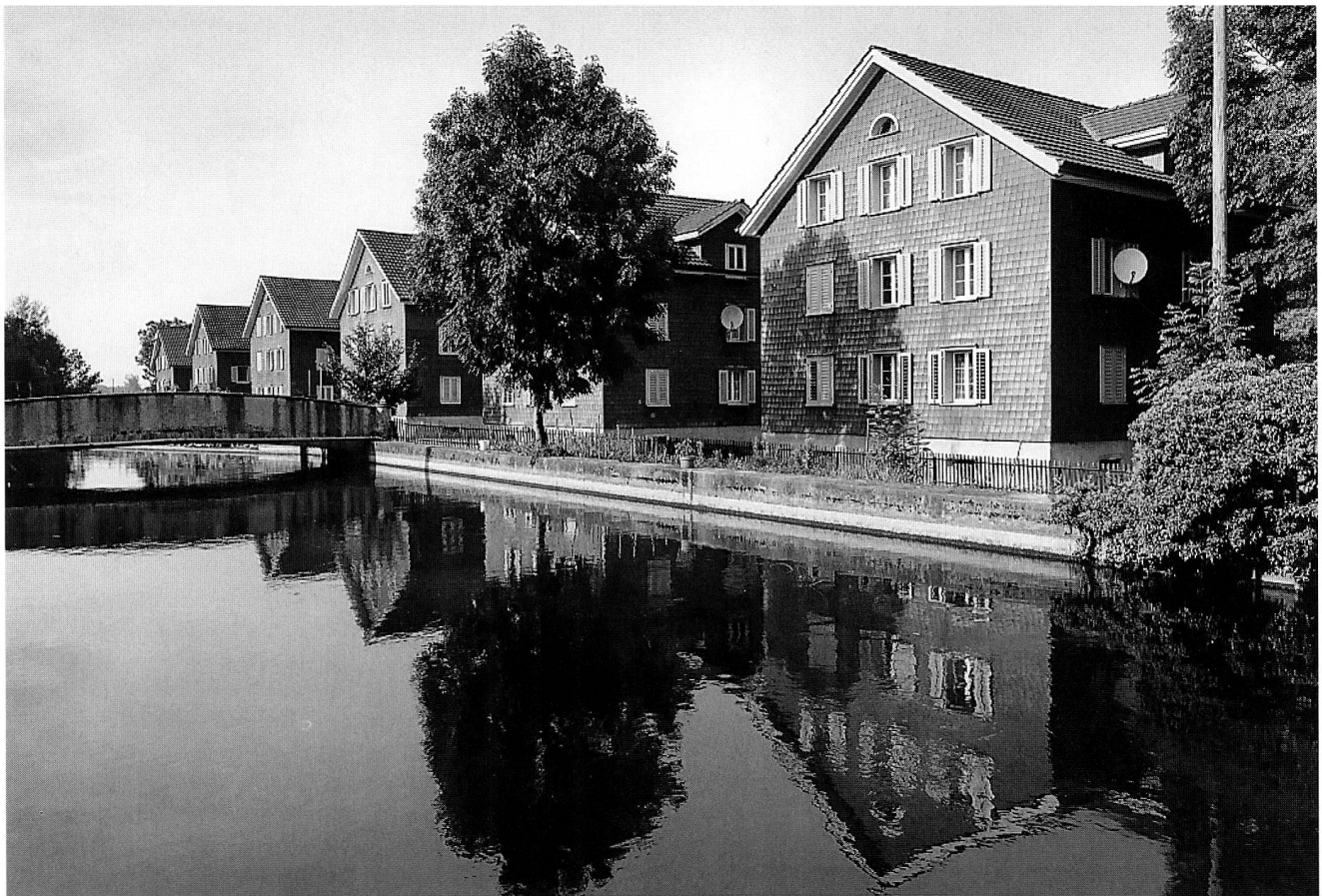
Abb. 2 Cham. Die 1866 erbaute Arbeitersiedlung in der Lorzenweid.
