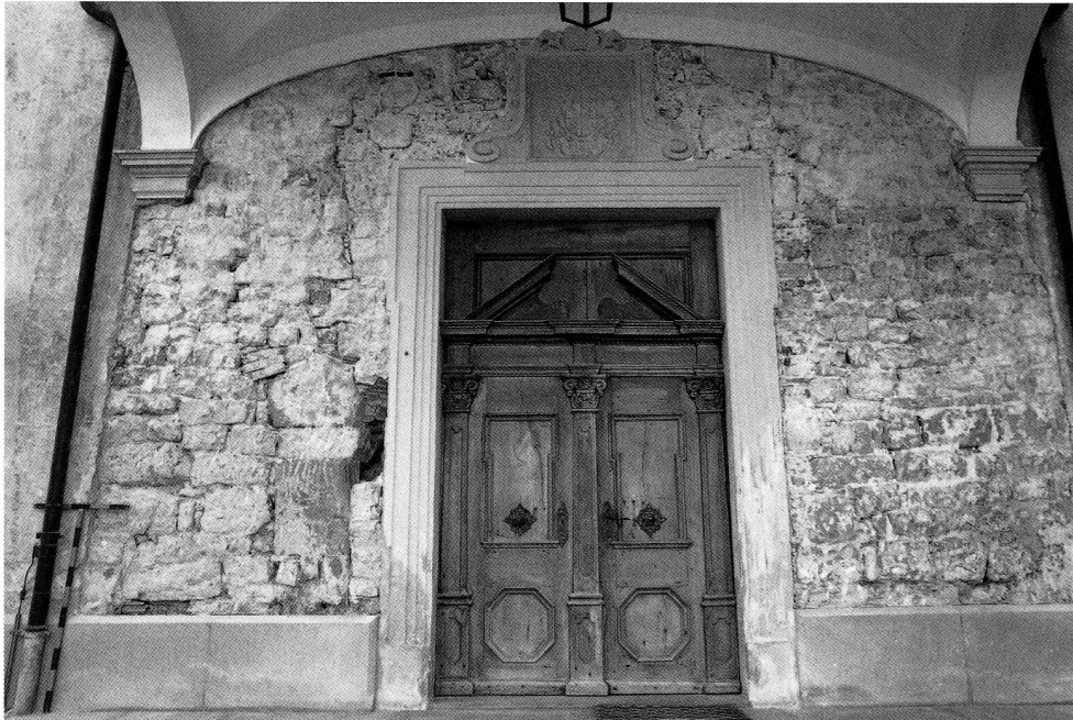
Abb. 12 Die 1997 freigelegten Befunde im Bereich des Vorzeichens an der Kirchenwestseite (vgl. Abb. 13). Einteilung der Messlatten in 10 cm.
