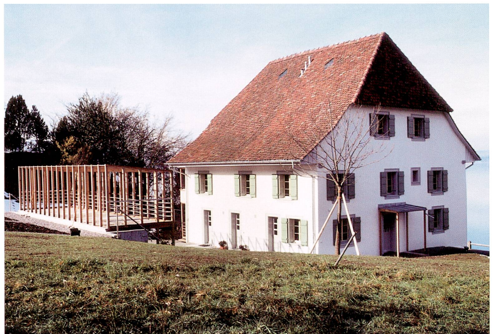
Abb. 27 Zug, Stolzengraben. Blick von Nordosten, nach der Restaurierung.
