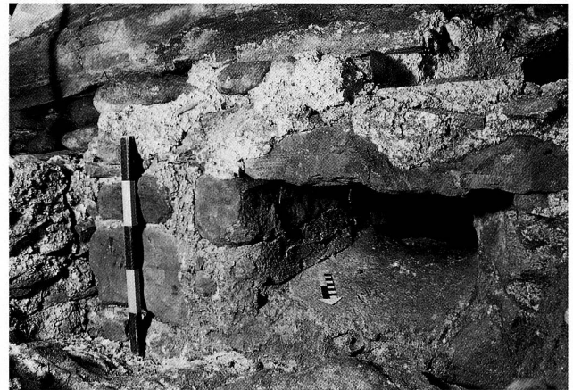
Abb. 4 Zug, Stolzengraben. Südmauer des Kellers, Innenseite. Fensterchen (vgl. Abb. 3) und Balkennegativ über dem Fenstersturz.
