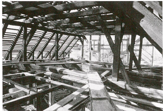
Abb. 16 Zug, Stolzengraben. Dachstuhl von 1546. Blick Richtung Nordwesten.
