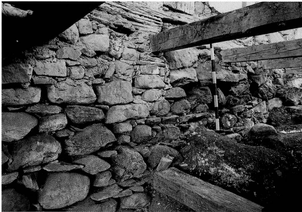
Abb. 3 Zug, Stolzengraben. Südfassade des Kellersockels, Aussenseite. Älteres lagiges Mauerwerk, rechts neben der Messlatte das zugehörige Fensterchen (vgl. Abb. 4).
