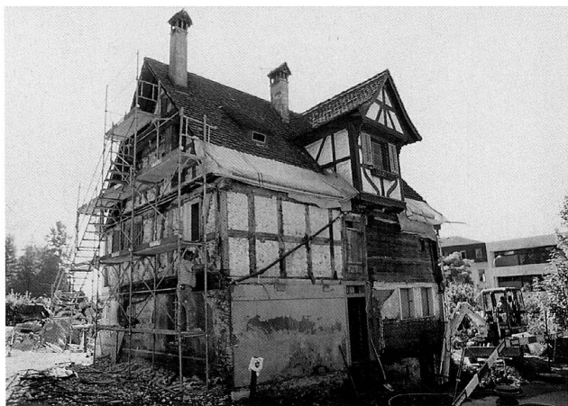
Abb. 33 Zug, Friedhofgärtnerei St. Michael. Nordostecke während der Restaurierungen 1997. Älterer Blockbauteil (rechts) und jüngeres Fachwerk (links).
