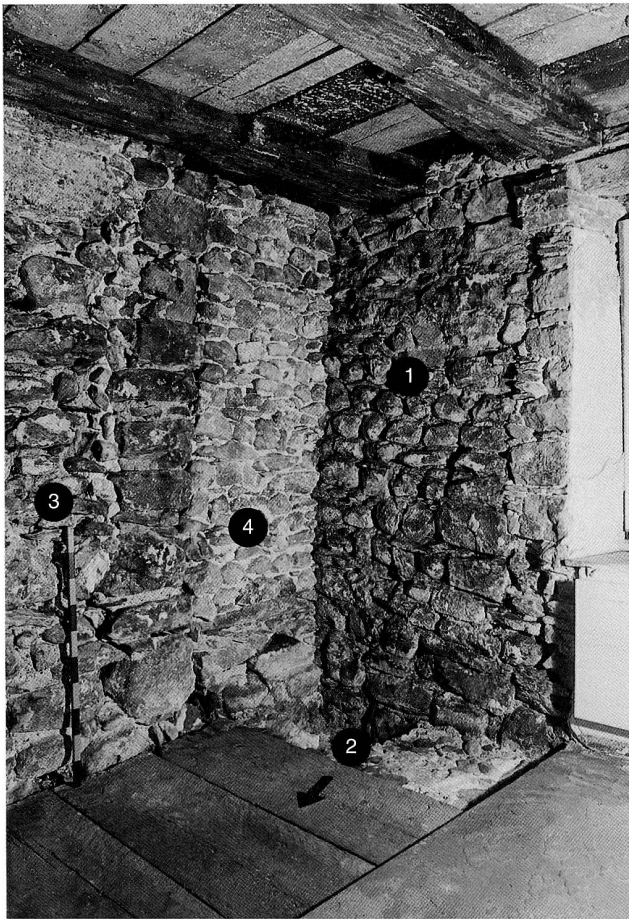
Abb. 6 Seehof, zweites Obergeschoss, Südostraum, Blick Richtung Südosten. 1 Stadtmauer. 2 Ursprünglicher Wehrgang. 3 Westwand der Liebfrauenkapelle (Aussenseite). 4 Zustufung im Bereich des ursprünglichen Umganges an der Mauerinnenseite.
