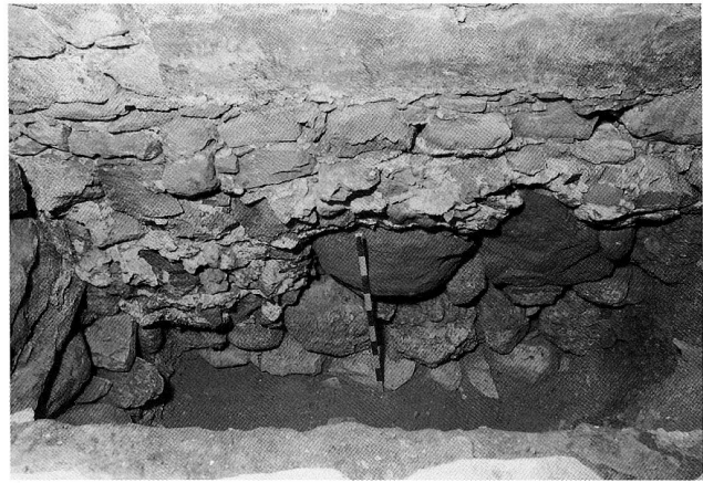
Abb. 7 Haus Santa Maria, Erdgeschoss, Raum 3. Innenseite der Nordwand. Im Bereich der Messlatte sind die tief liegenden Reste der Stadtmauer zu sehen (Einteilung der Messlatte in Dezimeter).
