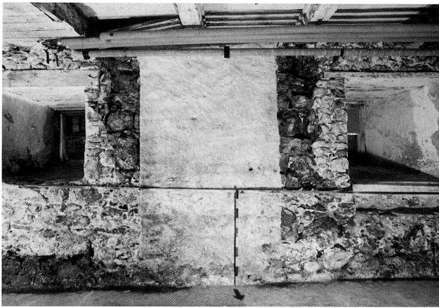
Abb. 4 Seehof, Erdgeschoss, Südostrum, Blick Richtung Süden. Die teilweise freigelegte Stadtmauer mit zwei jüngeren Fenstern. Der Schnitt Abb. 3 liegt wenig links des linken Fensters.
