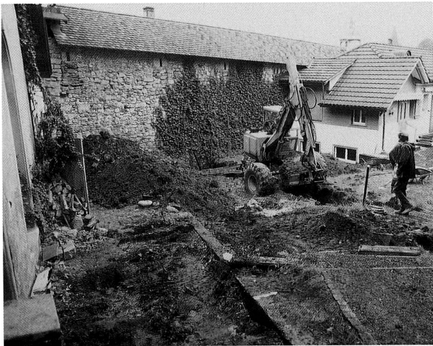
Abb. 22 Liegenschaft Bohlstrasse 7, Blick Richtung Nordwesten. Aussenseite der Stadtmauer. Sondierungsarbeiten mit dem Bagger.
