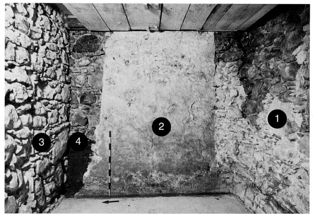
Abb. 5 Seehof, Erdgeschoss, Südostrum, Blick Richtung Osten, Befunde teilweise freigelegt. 1 Stadtmauer. 2 Westwand der Liebfrauenkapelle (Aussenseite). 3 Interne Trennwand des Seehofes. 4 Unterkante der Kapellenwand (ca. 0,8 m über dem modernen Boden). Die Fundamentunterkante der Stadtmauer im Bereich zwischen modernem Boden und Fundamentunterkante der Kapellen-Westwand konnte nicht genau bestimmt werden.
