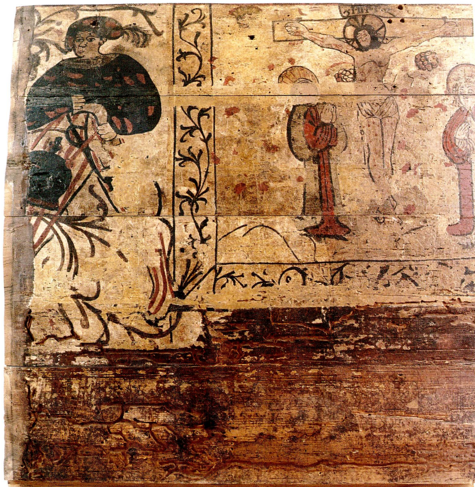
Abb. 1 Baar, Rathausstrasse 6/8. Erdgeschoss, Südwestraum. Bohlenmalereien, rechts Kreuzigungsszene mit Maria und Johannes, links Reisläuferdarstellung. Nach der Restaurierung, Bohlen ausgebaut. Grösse ca. 1,30 × 1,30 m.
