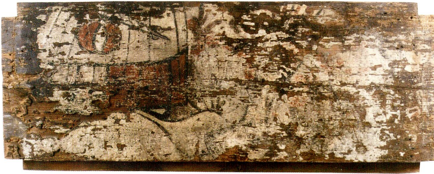
Abb. 11 Baar, Rathausstrasse 6/8. Fragment einer Bohlenmalerei, links unterer Viertel einer Frauengestalt, rechts Bein mit «Kuhmaul»-Schuh. Bohlen ausgebaut, nach der Reinigung. Grösse 37×100 cm.
