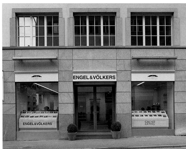
Abb. 6 Haus Neugasse 15 mit vollständig zugebauter ehemaliger Arkade.
