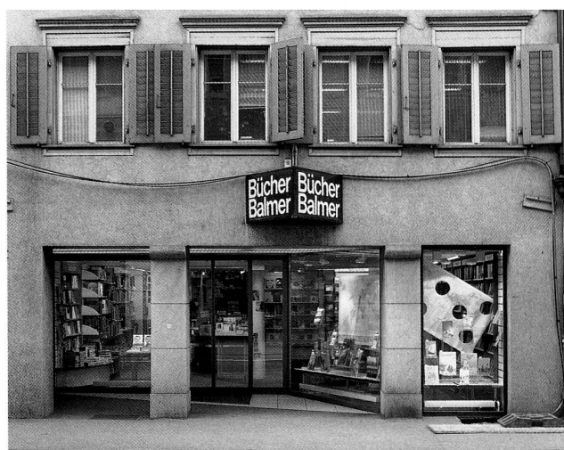
Abb. 5 Haus Neugasse 12 mit zum Teil zugebauter Arkade.
