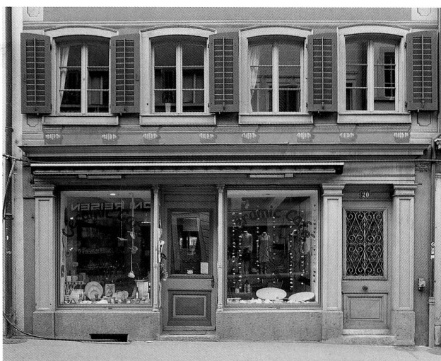
Abb. 3 Haus Neugasse 20 mit der noch bestehenden, um 1875 eingebauten Ladenfront mit den Gusseisensäulen links und rechts der Ladentüre.
